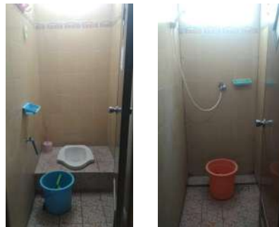
Gambar 13 Toilet dan tempat mandi komunal
