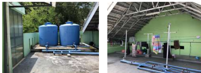
Gambar 14 Ruang cuci jemur
