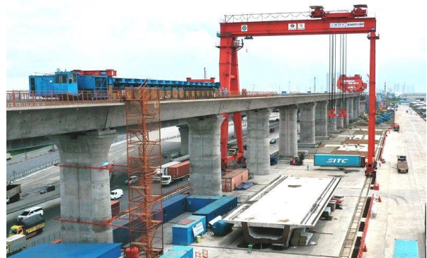
Gambar 2. Pembangunan Infrastruktur KC Jakarta-Bandung Sumber: kanalbekasi.com
