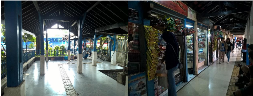
Gambar 19. Sistem Bangunan didominasi koridor-koridor penghubung di dalam Terminal Leuwipanjang
