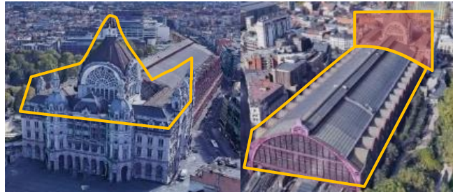
Gambar 25 Elemen pelingkup kaki pada bangunan Antwerp Central Station . Sumber: Google Maps dan Google Globe View, 2021.
