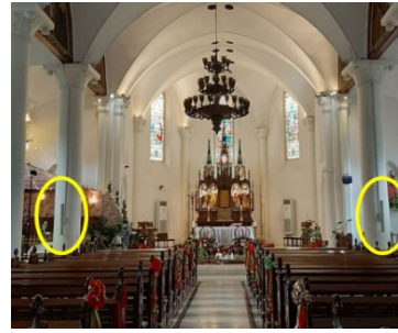
Gambar 3. Letak pengeras suara pada ruang ibadah gereja Katolik St. Yusuf Gedangan
