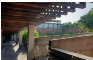
Gambar 22. Fasad Kayu Bengkirai yang Menerus Menjadi Plafon
