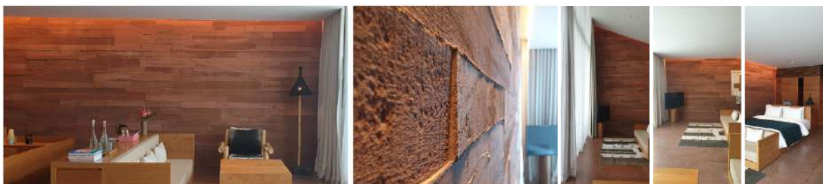
Gambar 18. Dinding Beton Motif Kayu
