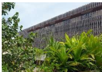
Gambar 22. Fasad Kayu Bengkirai yang Menerus Menjadi Plafon
