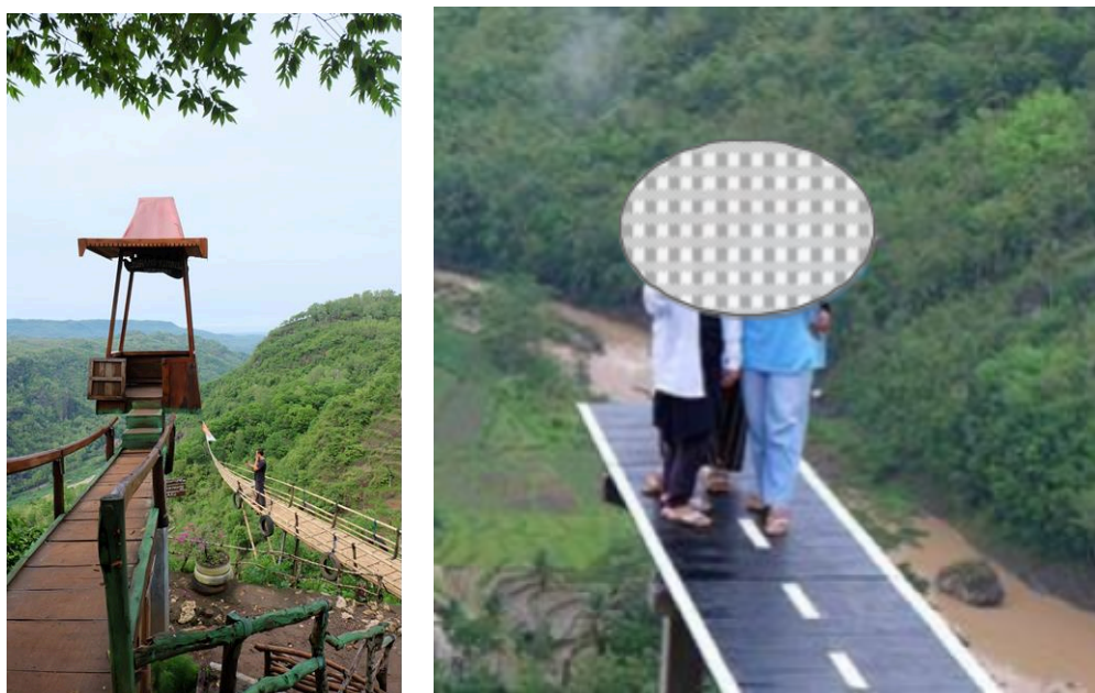
Gambar 6. Pengabaian Aspek Keselamatan pada Objek Wisata
