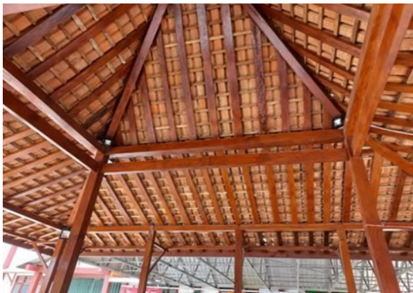
Gambar 9. Detail pada Bangunan Limasan Kalurahan Mangunan (Kolom – Balok – Rangka Atap dan Detail Ukiran pada Balok Atap)
