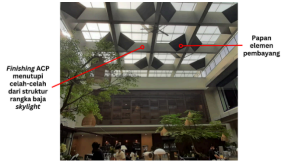
Gambar 4.4 Elemen pembayang pada skylight
