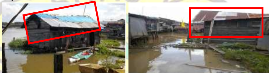
Gambar 14. Kerusakan Pada Elemen Atap
