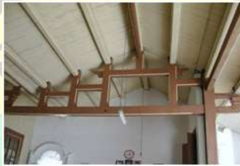
Rangka Penyangga Atap Yang Diperlihatkan Sebagai Dekorasi Pada Rumah di Daerah Pecinan
