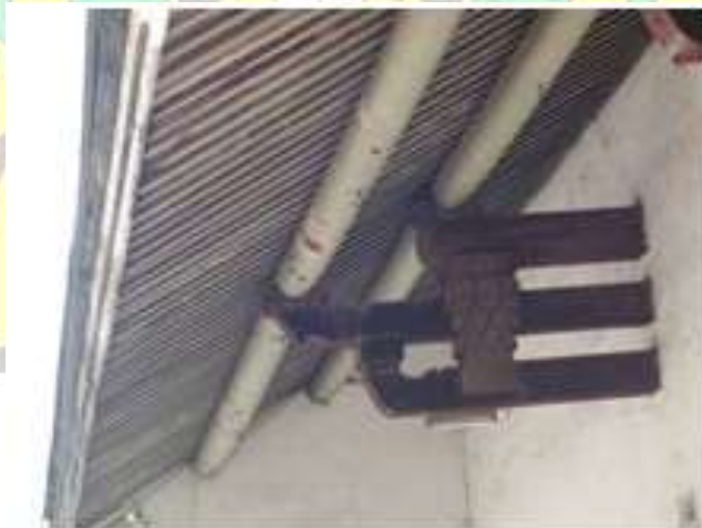
Gambar 3.10 Struktur Penyangga Atap Yang Menjadi Salah Satu Ciri Khas Rumah-Rumah Orang Cina di Daerah Pecinan
